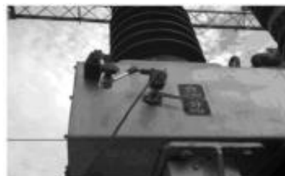
35KV SF6 开关传感器安装
